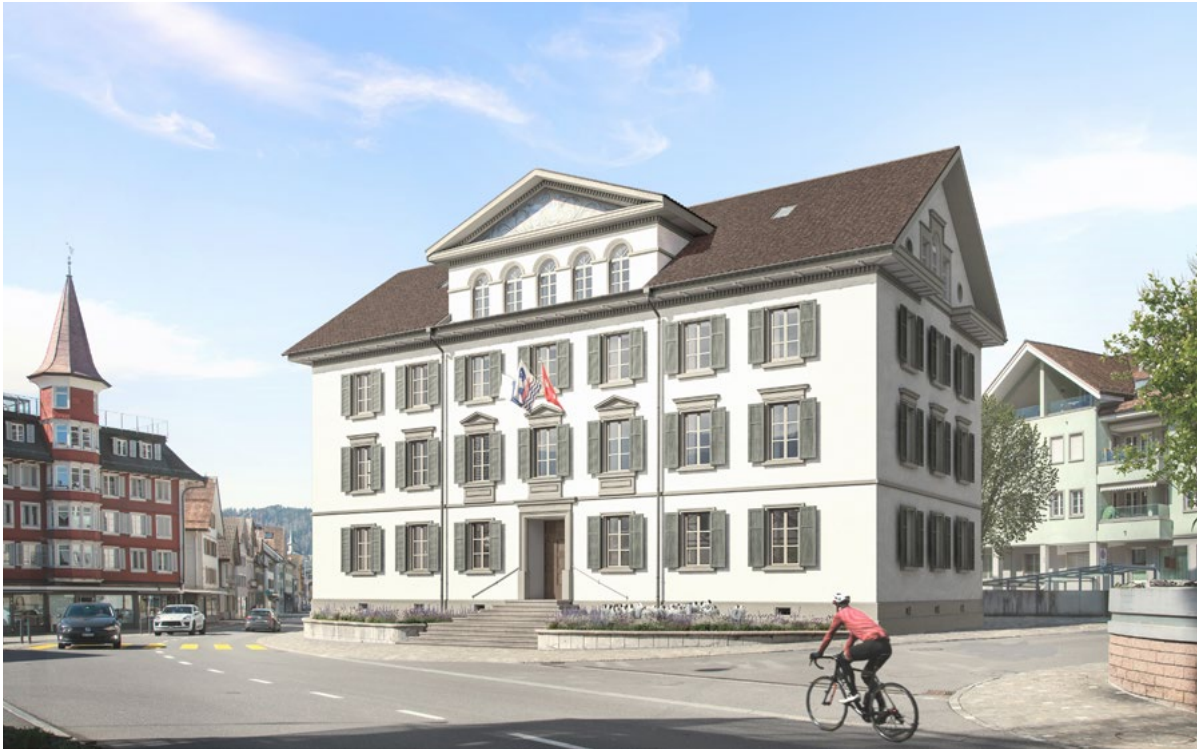
Aussenvisualisierung nach Totalsanierung
